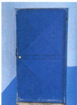
Foto 1: Sustitución de Puerta y Pintura en muro interior y exterior.
