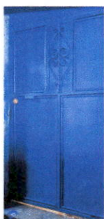
Foto 3: Mantenimiento de estructura lijado, cepillado y aplicación de pintura.
