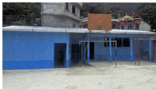
Foto 6: Sustitución de canal de metal y pintura en muro interior y exterior.
